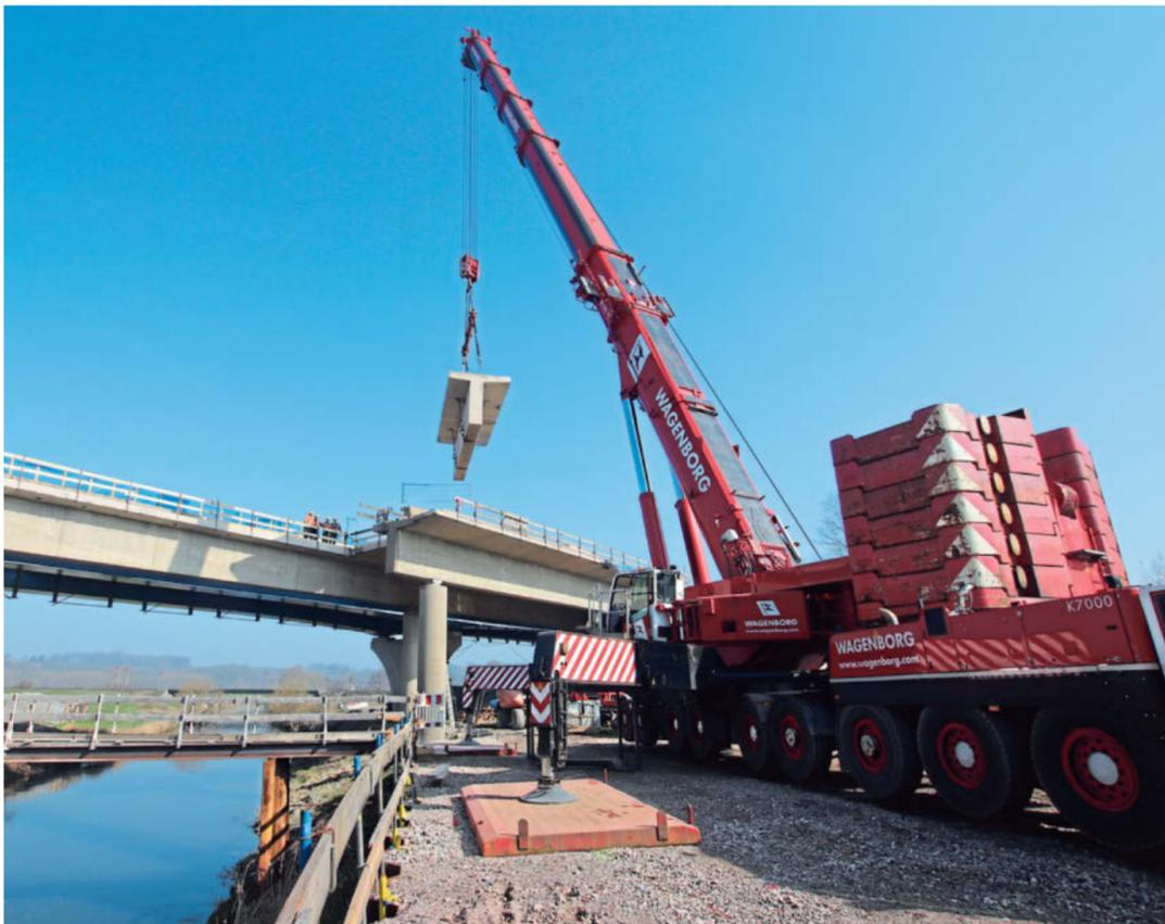
Die Werrebrücke der A 30 zwischen den Anschlussstellen Löhne und Kirchlengern wurde komplett saniert. Stück für Stück ist das Bauwerk dafür zuvor zerschnitten worden.
